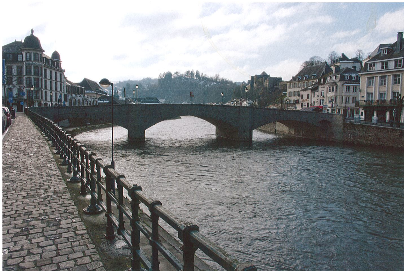
Le pont de Liège, porte d'entrée de la vieille cité.
